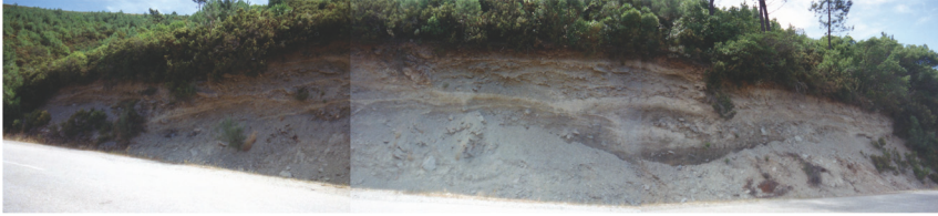
Fot. 6 - Aspecto geral do depósito curviflúvio do Km 164,4, da Estrada Vide-Pedras Lavradas. (Fonte: L. Lourenço, 1996, p. 238-9).
