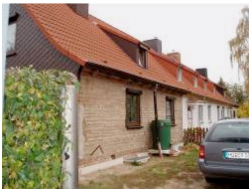
Fig. 3 e Fig. 4. Moradias e blocos habitacionais em taipa, construídas pós II Guerra Mundial, em Múnich, na Alemanha (Créditos: Maria Fernandes, 2004).
